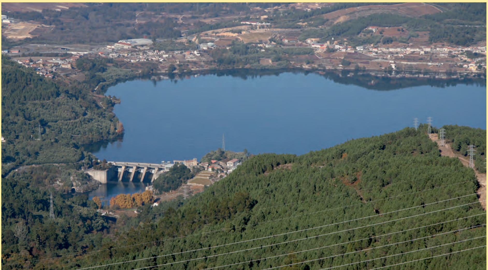
Castrelo de Miño: inaugurada en 1969. O encoro ocupa 1.303 ha, ten unha capacidade de 60 hm³ e unha presa de 29 m de altura. A presa está situada entre os concellos de Castrelo do Miño e Ribadavia.
