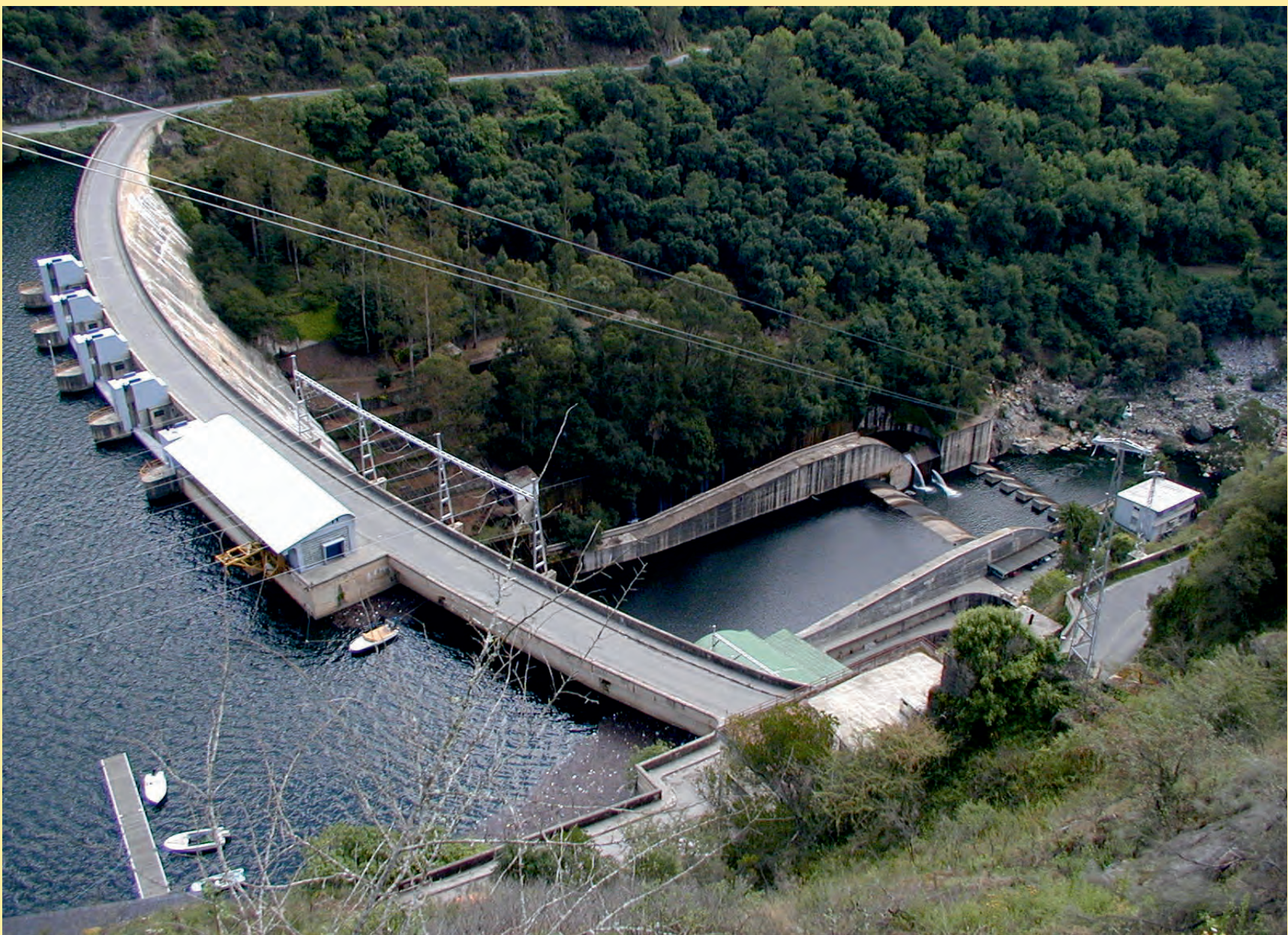
Os Peares. Comezouse a construír en 1947 e inaugurouse en 1955. Ocupa unha superficie de 535 ha. A presa está situada entre Carballedo e Pantón. Volume de encoro 182 hm³, altura da presa 94 m.
