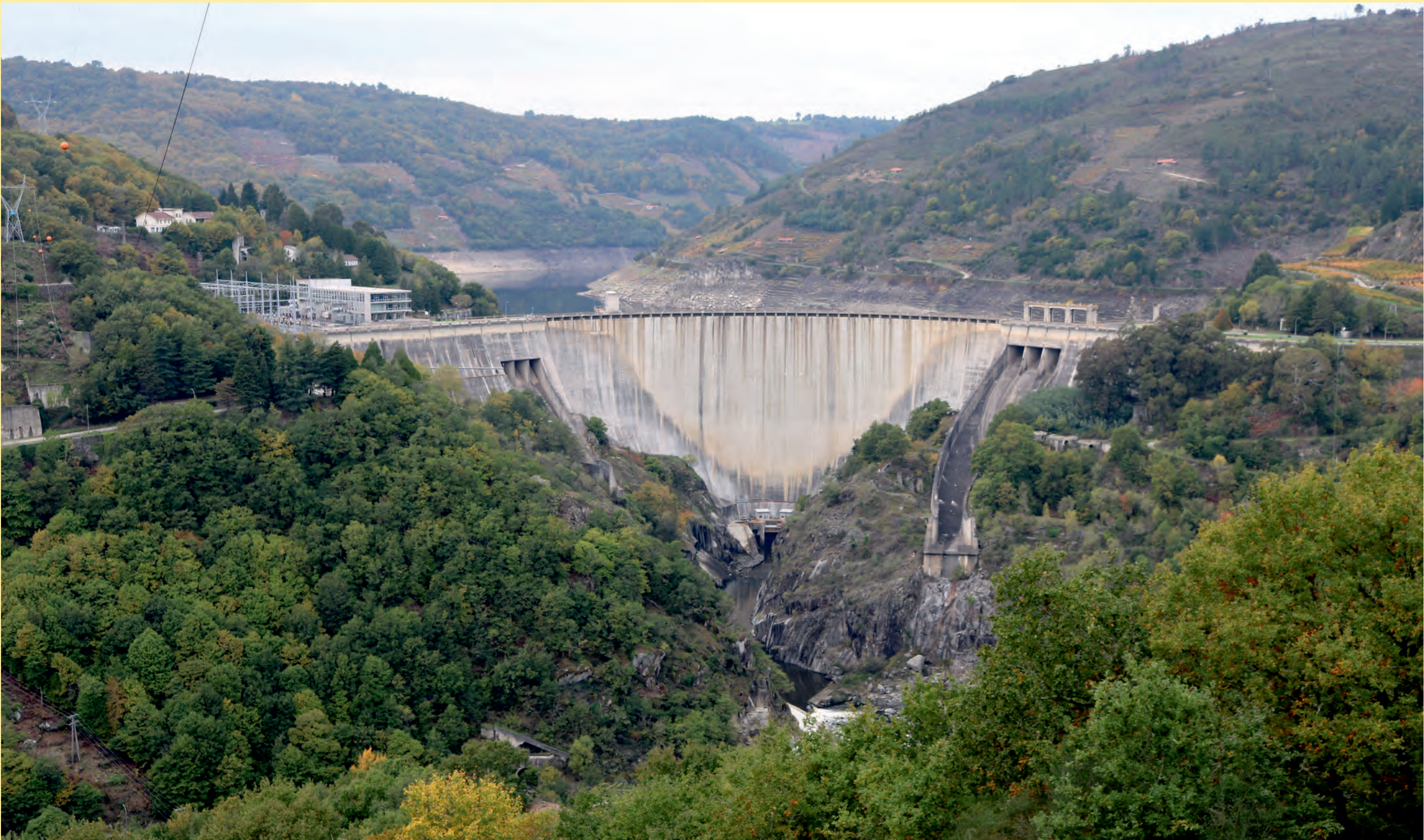
Belesar: inaugurada en 1963, a máis grande do Miño, con capacidade de 654,5 hm³, ocupa unha superficie de 2.000 hectáreas (concellos de Taboada, Chantada, O Saviñao, Guntín Paradelá, O Páramo e Portomarin), cunha cola de 50 km e unha presa de 129 m de altura. Baixo as súas augas desapareceron Castro Candaz, Portomarin, Mourulle, Pincelo, Aberledo, Portomefe...
